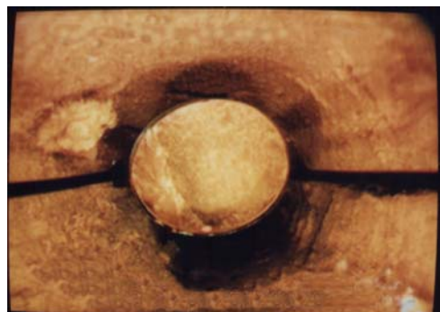
Fernsehbild einer Verockerung
